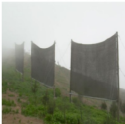
Filets à nuages : système passif de captation de l'eau contenue dans le brouillard
