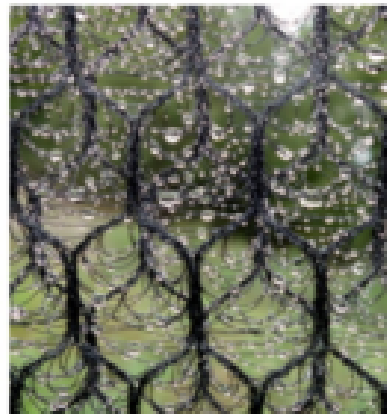
Filets à nuages : système passif de captation de l'eau contenue dans le brouillard
