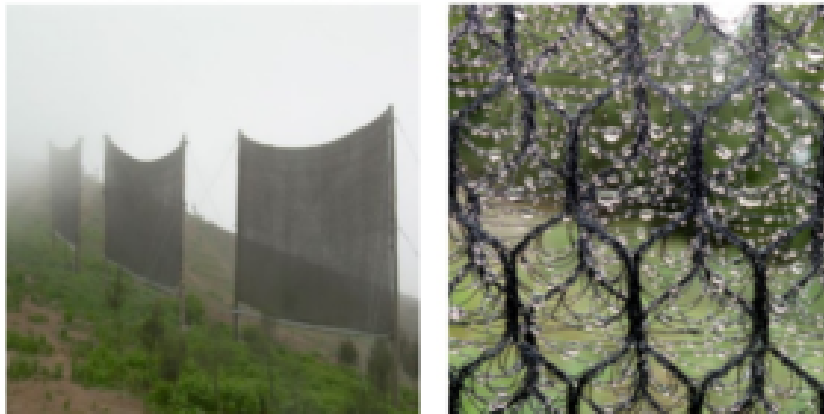
Filets à nuages : système passif de captation de l'eau contenue dans le brouillard
