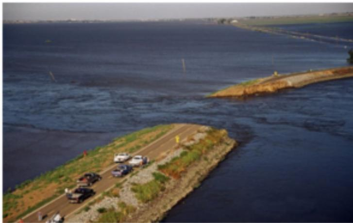
Rupture de digue par surverse ©Université de Stanford
