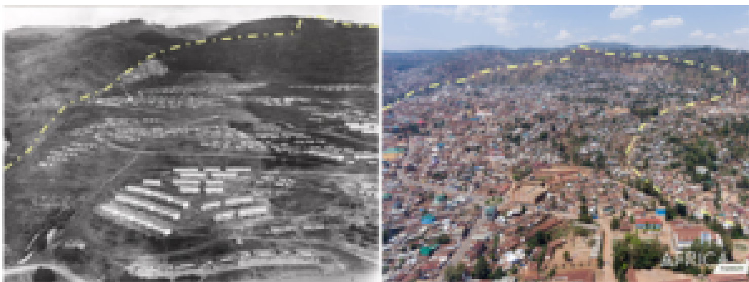
Le grand glissement de terrain à Bukavu en 1959 (à gauche) et en 2018 (à droite). La ligne pointillée jaune délimite la partie supérieure du glissement de terrain. L'escarpement très raide qui délimite cette partie du glissement de terrain fait 100 mètres de haut. Photo de gauche : © MRAC ; photo de droite : © Antoine Dille / MRAC
