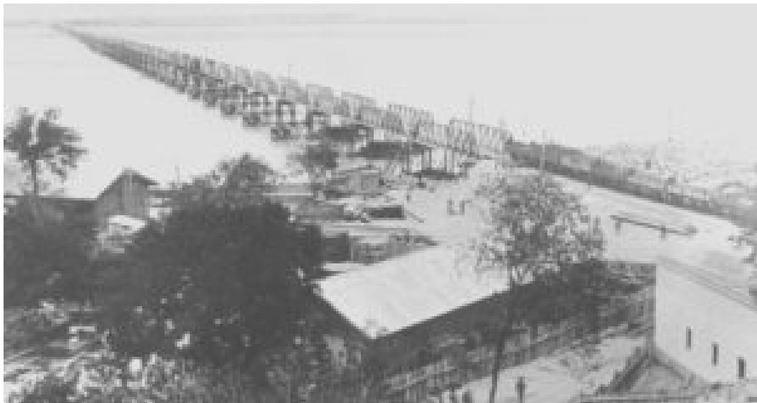
Le pont sur le fleuve Jaune, le plus long pont ferroviaire du monde (3 km) à l'époque © Archives Jean Jadot - Cliquez pour agrandir
