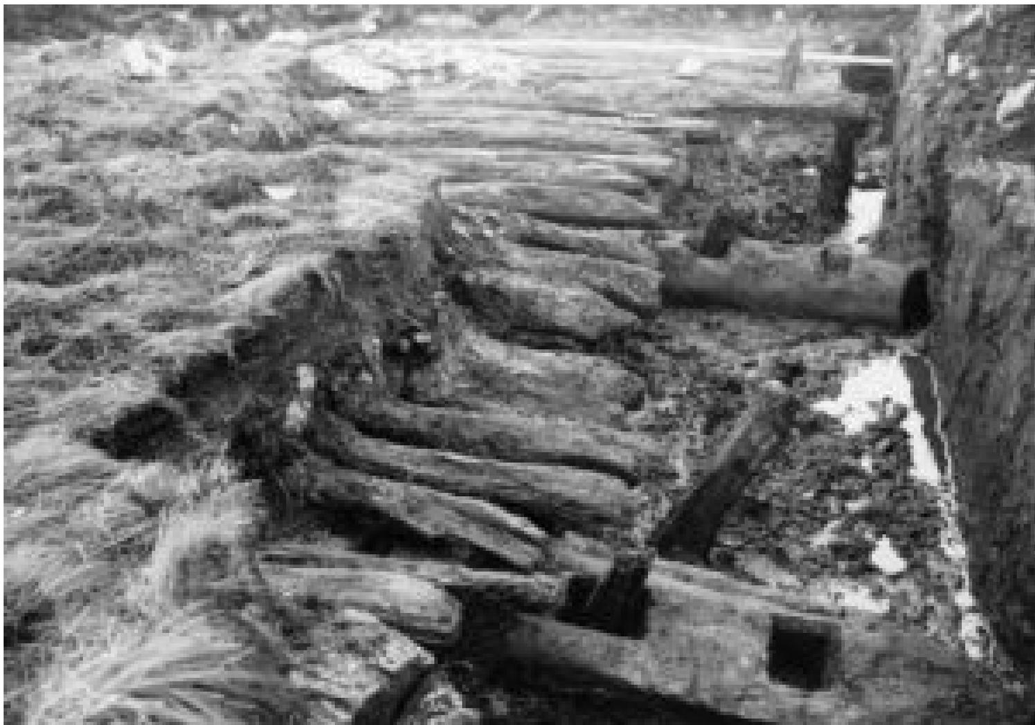
Fouille de la Via Mansuerisca (Pavé Charlemagne, site des Biolettes) - Madriers équarris percés de deux mortaises, disposés transversalement au sens de la voie, maintenus au sol par des chevilles quadrangulaires (1933-1934) - © Station Scientifique des Hautes Fagnes / ULiège
