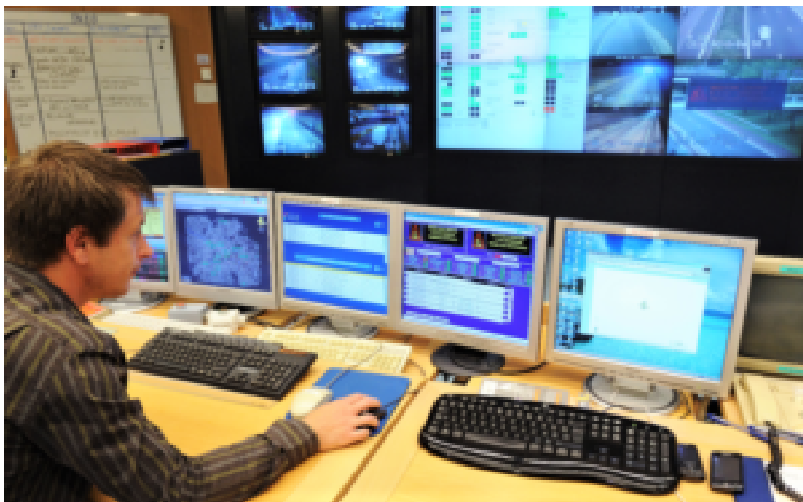
La salle de gestion du trafic de Bruxelles Mobilité située près de la Gare du Nord. L'objectif est de contrôler de façon centralisée et intelligente tous les carrefours à feux de la région bruxelloise © Bruxelles Mobilité
