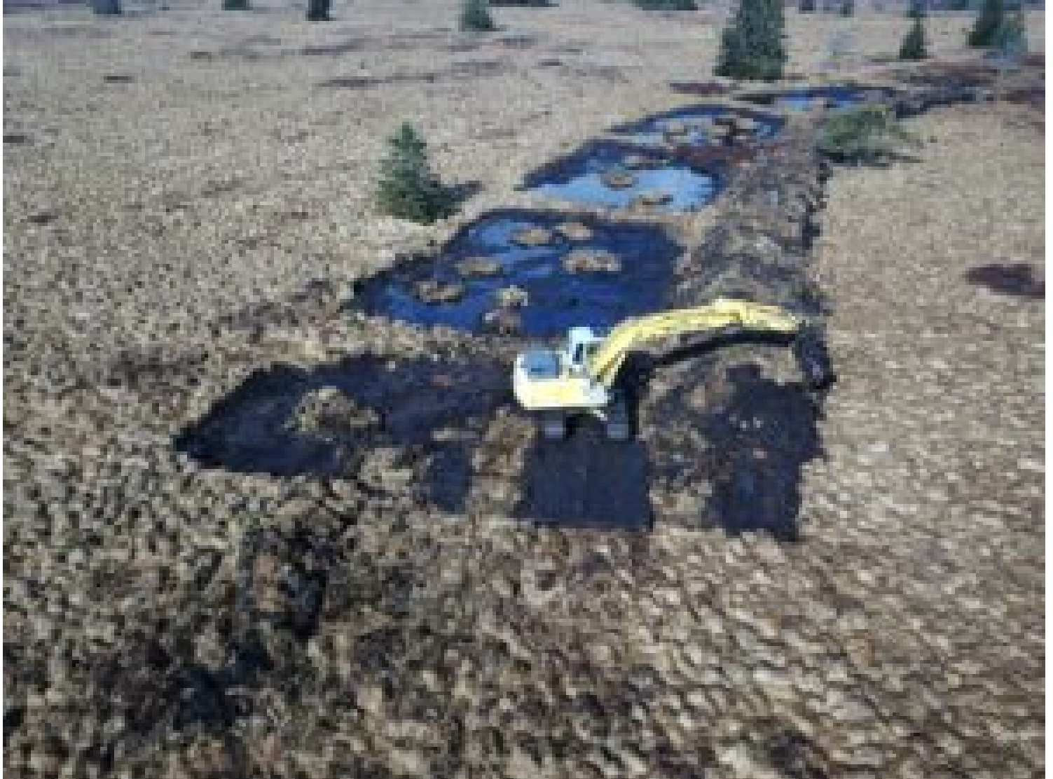
Erection d'une digue d'envoiement © DNF / SPW
