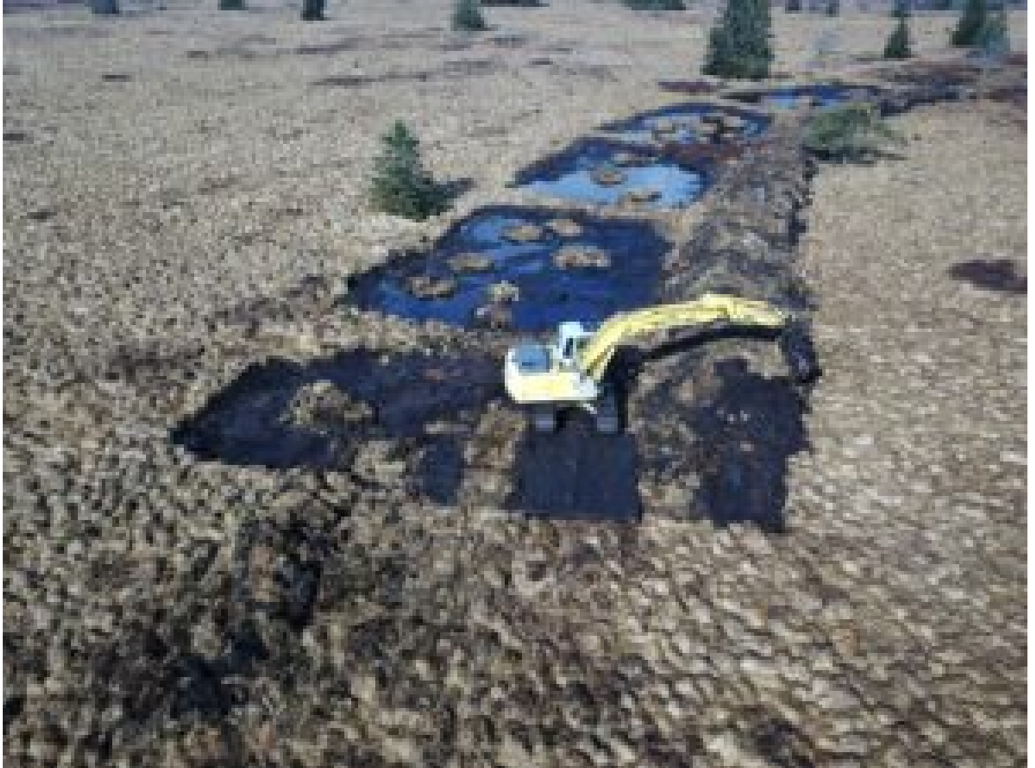
Erection d'une digue d'envolement © DNF / SPW
