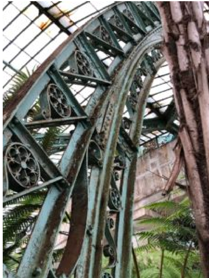
Détail de l'architecture des serres de Laeken © Christian Du Brulle
