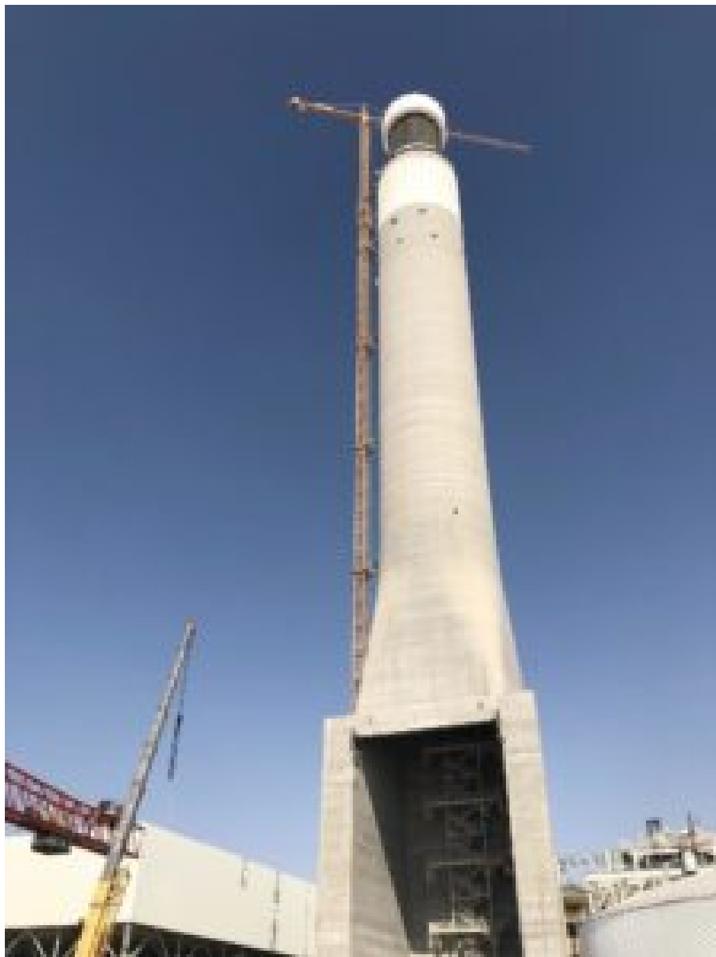
Tour surplombée par le récepteur solaire à sels fondus © Christian Du Brulle
