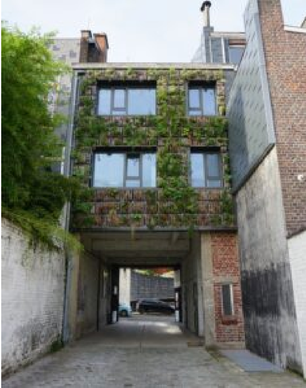
Façade de Novacitis (Liège), à l'arrière du bâtiment, végétalisée par VIVUS © Laetitia Theunis
