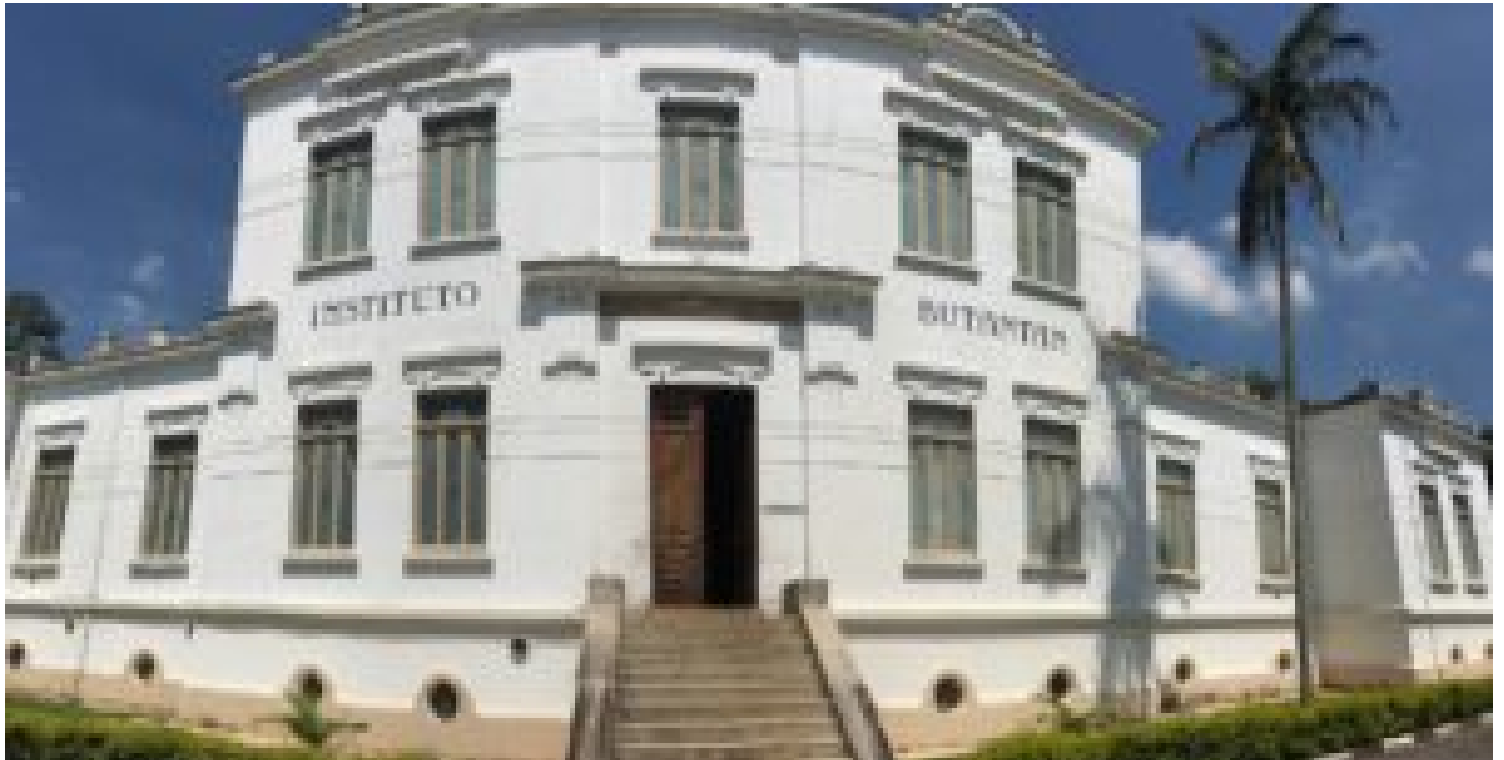
Le bâtiment historique de l'Institut Butantan à Sao Paulo © Christian Du Brulle
