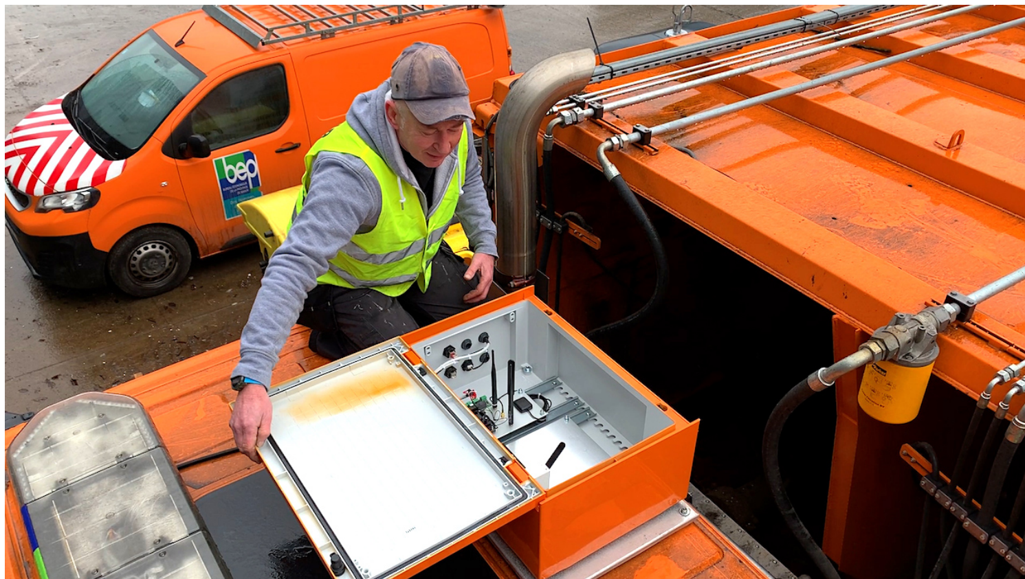
Installation d'un "hub" sur la cabine d'un camion sentinelle du BEP. © BEP
