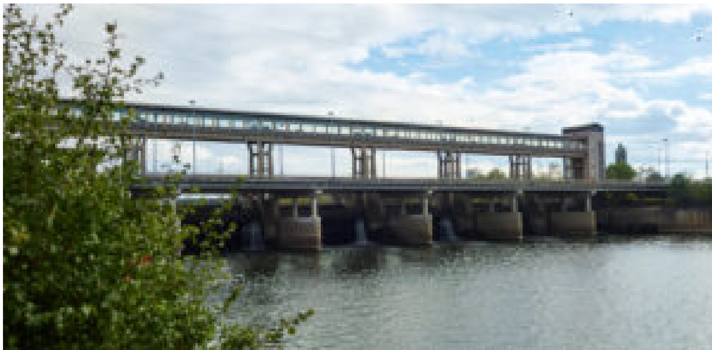
Barrage de Lixhe © Luminus
