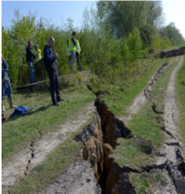
Sol fissuré après l'effondrement de la carrière de la Malogne à Mons en 2015 © SPW
