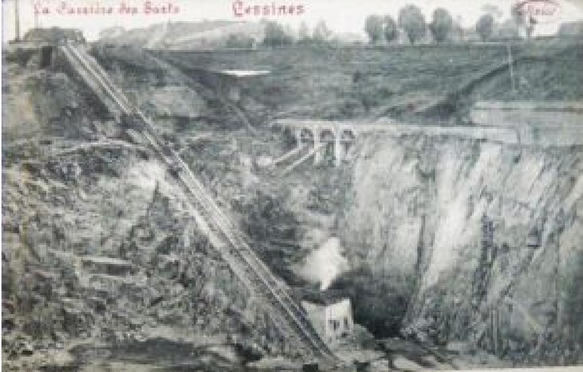
Vue de la carrière des Sarts à Lessines. "On distingue, dans le tiers supérieur, les terrains de découverte dont le bas est masqué par endroits par un mur de soutènement des terres meubles. Le bâtiment massif en bas d'où sort de la vapeur est interprété comme une machine à vapeur permettant la remontée des eaux d'infiltration", expliquent les auteurs © « Du porphyre et des Hommes au Pays des « Cayoteux » » par Eric Goemaere et Marina Cabidoche/ IRSNB
