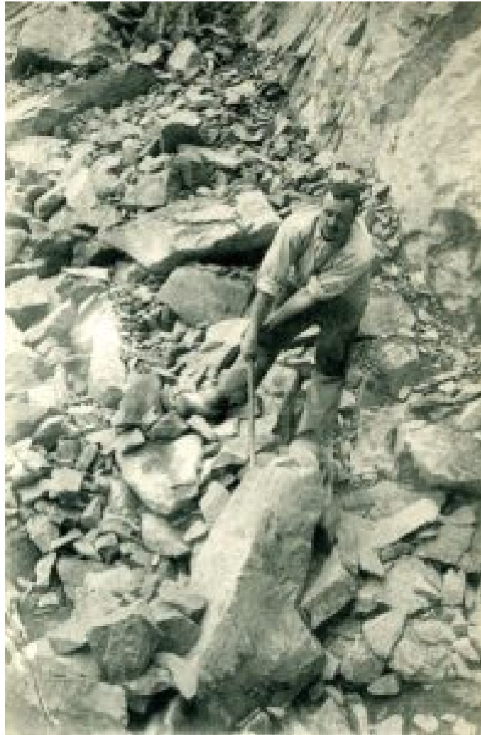
Ouvrier déplaçant un bloc au moyen d'une barre à mine © « Du porphyre et des Hommes au Pays des « Cayoteux » » par Eric Goemaere et Marina Cabidoche/ IRSNB
