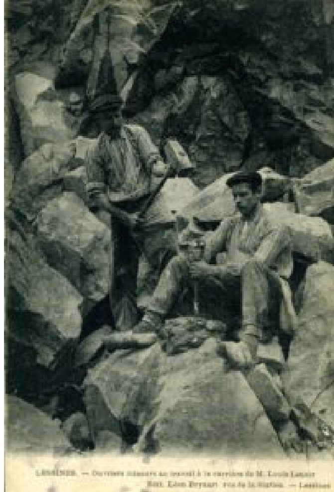
Foration manuelle secondaire par des ouvriers mineurs pour placer les pétards afin de segmenter les gros blocs de porphyre. "A noter la masse de glaise qui a pour fonction de capter les éclats éventuels, et donc de protéger les yeux des ouvriers", commentent les auteurs © « Du porphyre et des Hommes au Pays des « Cayoteux » » par Eric Goemaere et Marina Cabidoche/ IRSNB
