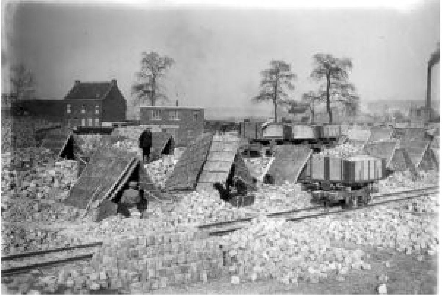
Chantier de surface de la carrière de Willocq montrant le travail des épinceurs. "Des empilements de pavés montrent les produits finis. Un système de wagonnets sur rails à voie métrique permet de transporter les pavés de porphyre", notent les auteurs. Les ouvriers sont assis sous des abris faits de planches et de paille : cela leur permet d'être protégés du soleil et du vent. © « Du porphyre et des Hommes au Pays des « Cayoteux » » par Eric Goemaere et Marina Cabidoche/ IRSNB
