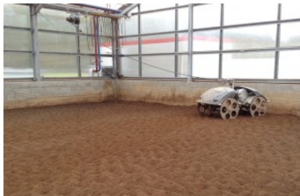
Serre de séchage des boues, L'Oréal - Libramont
