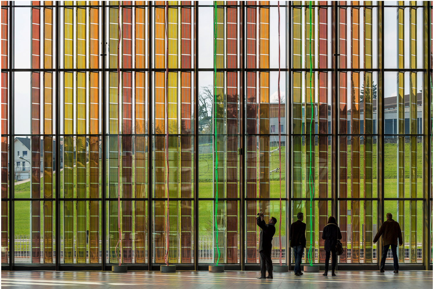
Cellules de Graetzel sur la facade du palais des congrès de l'EPFL
