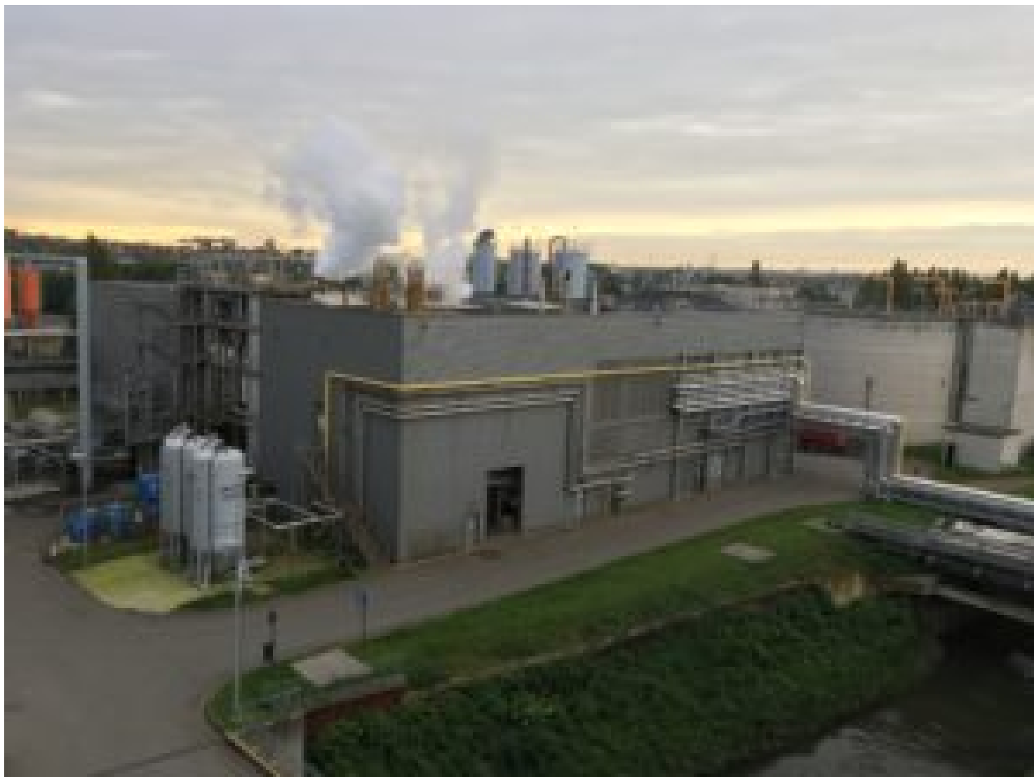
Station d'épuration de Bruxelles Nord © Natacha Brion - Cliquez pour agrandir
