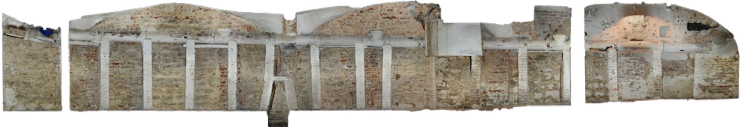
Mur nord de la cave, présentant des pans de murs datant d'époques différentes © urban.brussels - ULB
