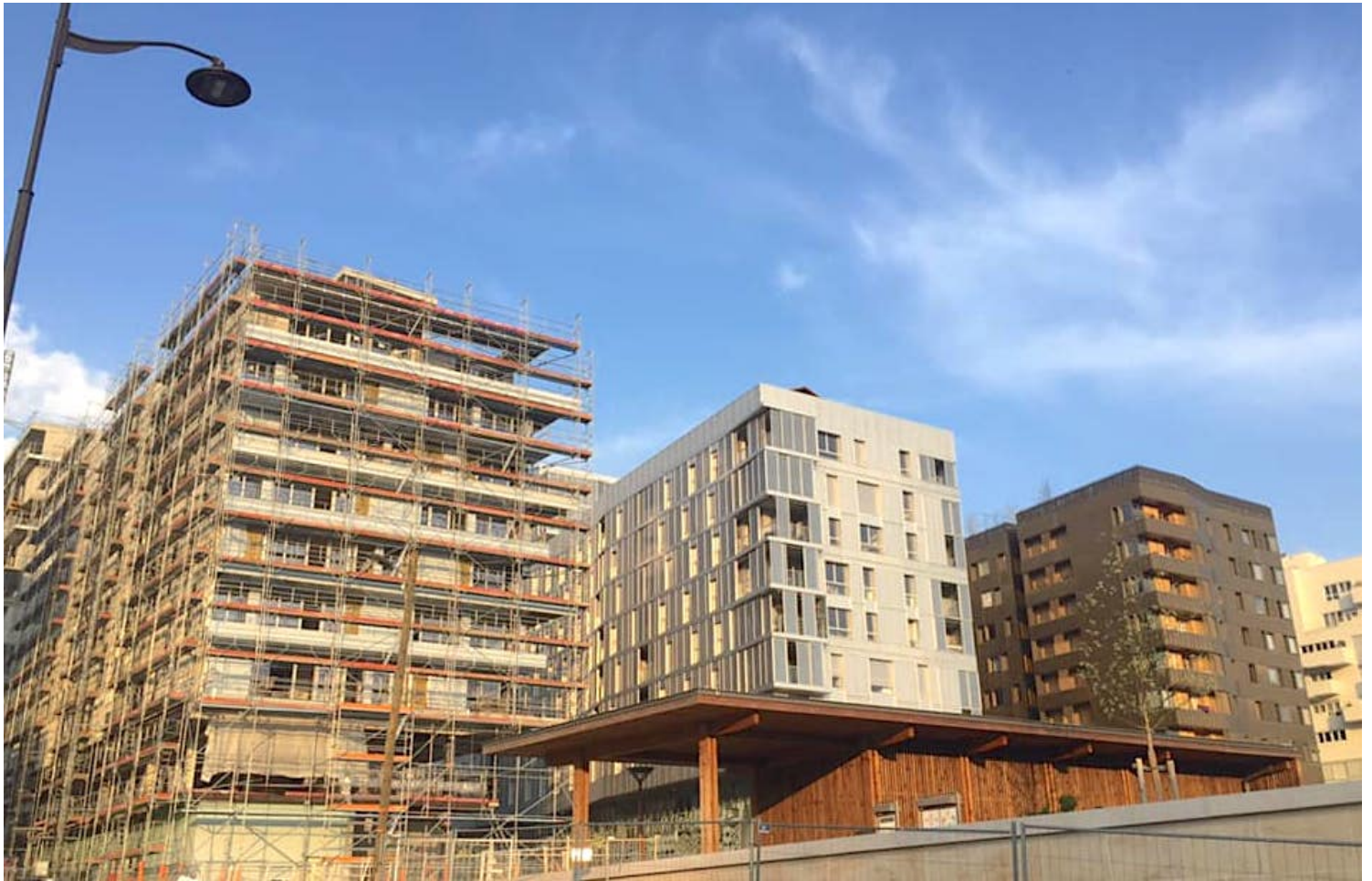
Port-au-Prince, immeubles en travaux.
