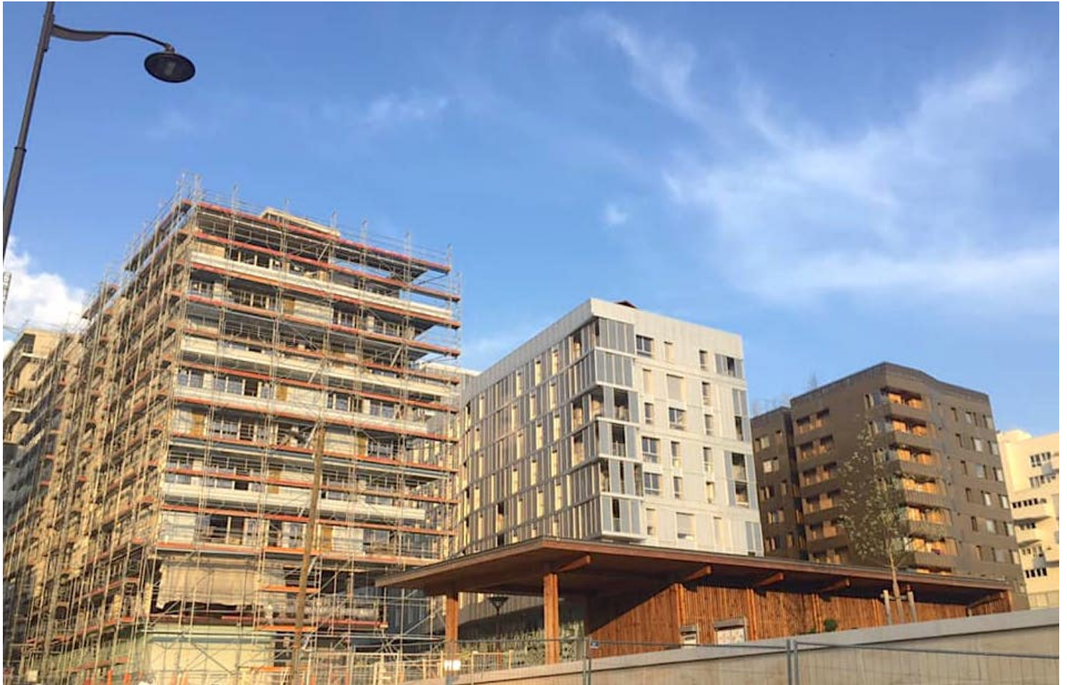
Port-au-Prince, immeubles en travaux.
