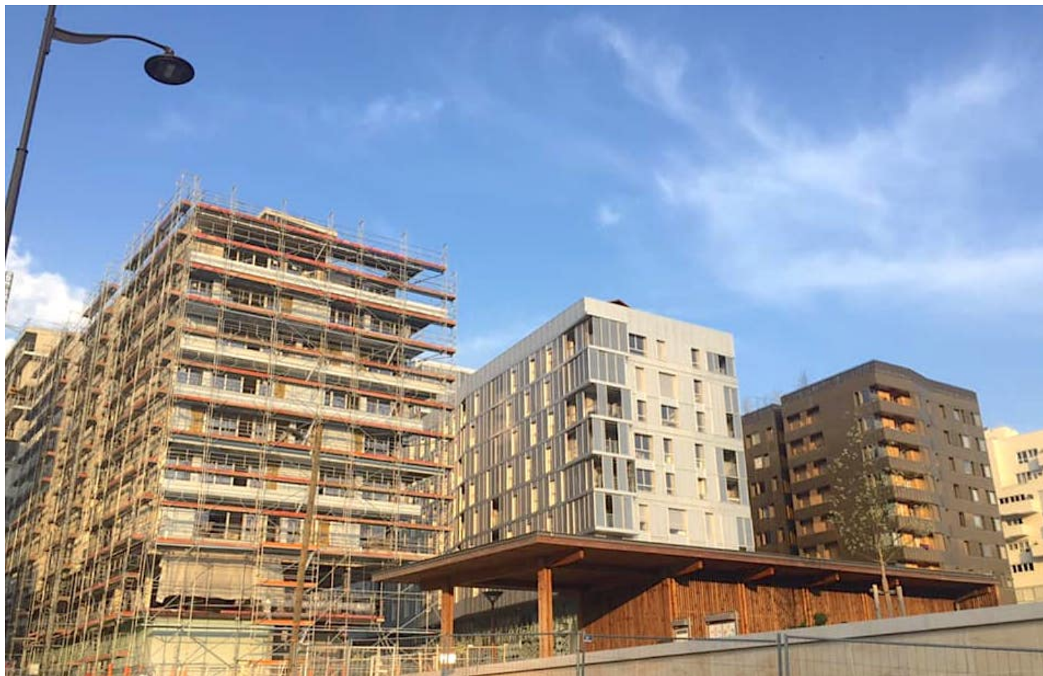
Port-au-Prince, immeubles en travaux.
